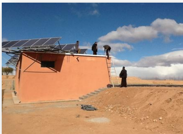
Installation des panneaux solaires sur la station de pompage
