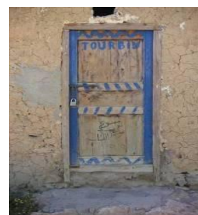
Porte du local de la turbine
