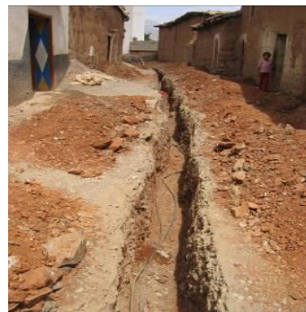
Travaux de mise à niveau du réseau, Ouneine
