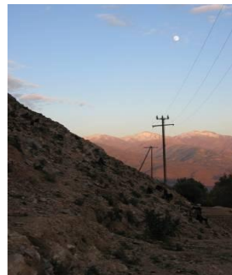
Raccordement au réseau national
